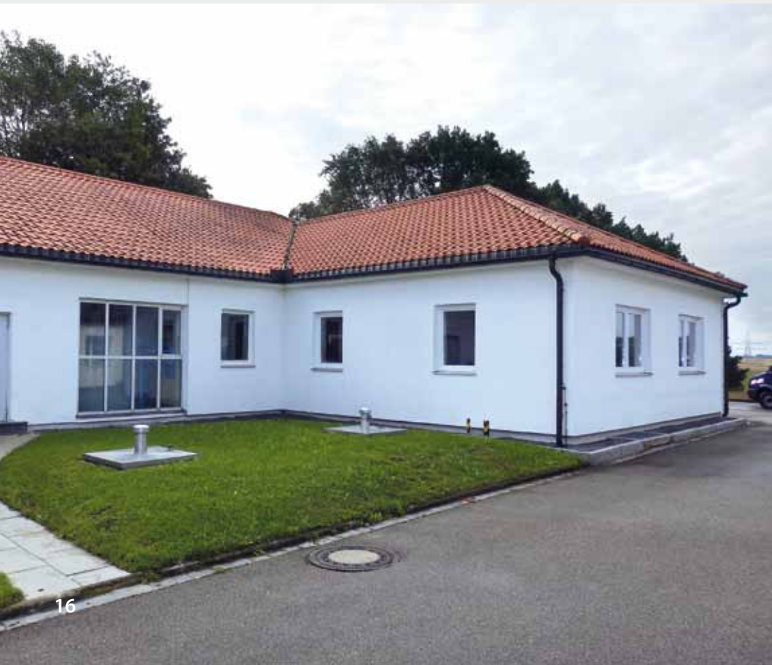
Gebäude der Aufbereitungs- anlage Großberghofen
