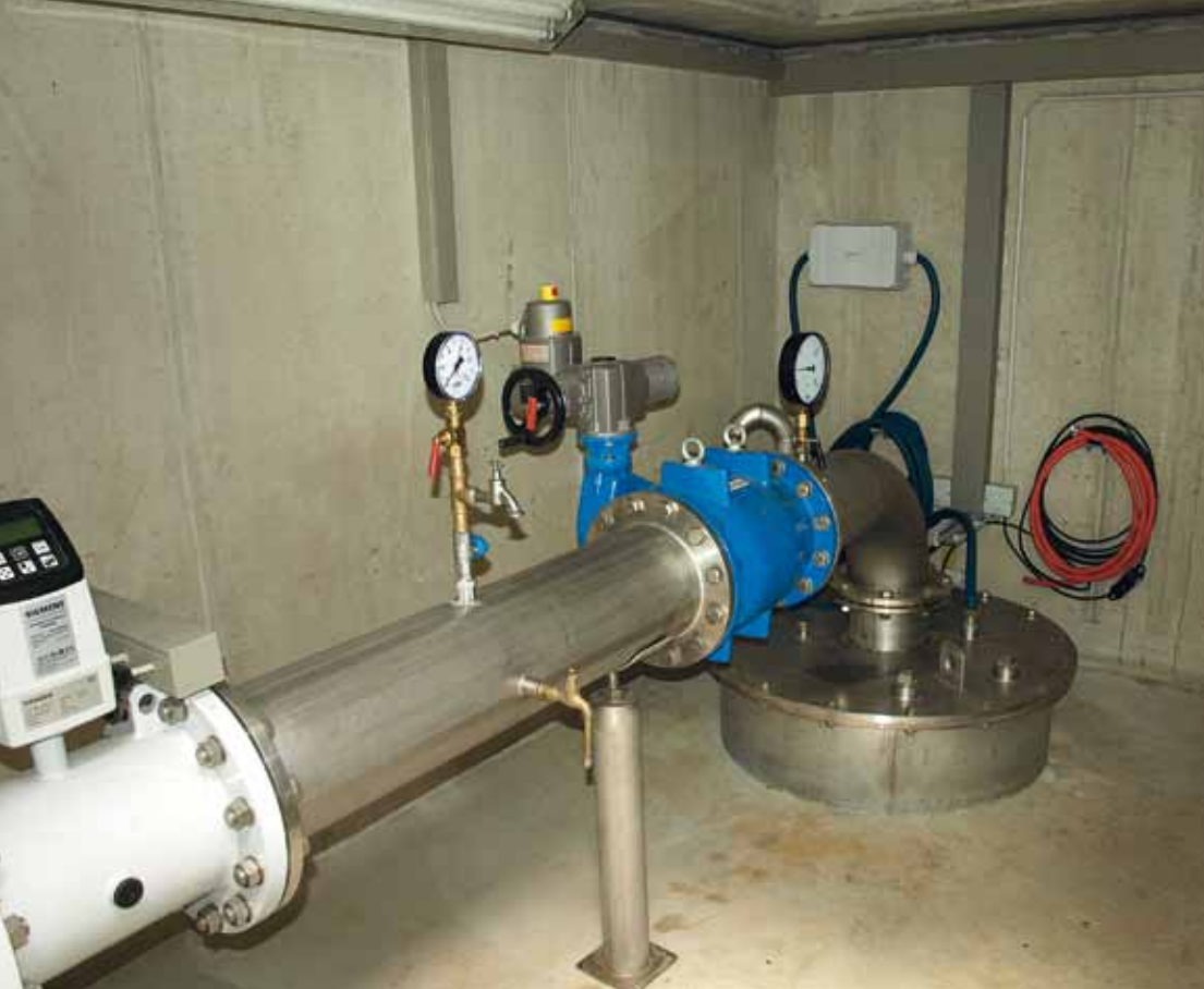
Innenansicht Brunnen bei Sulzemoos
